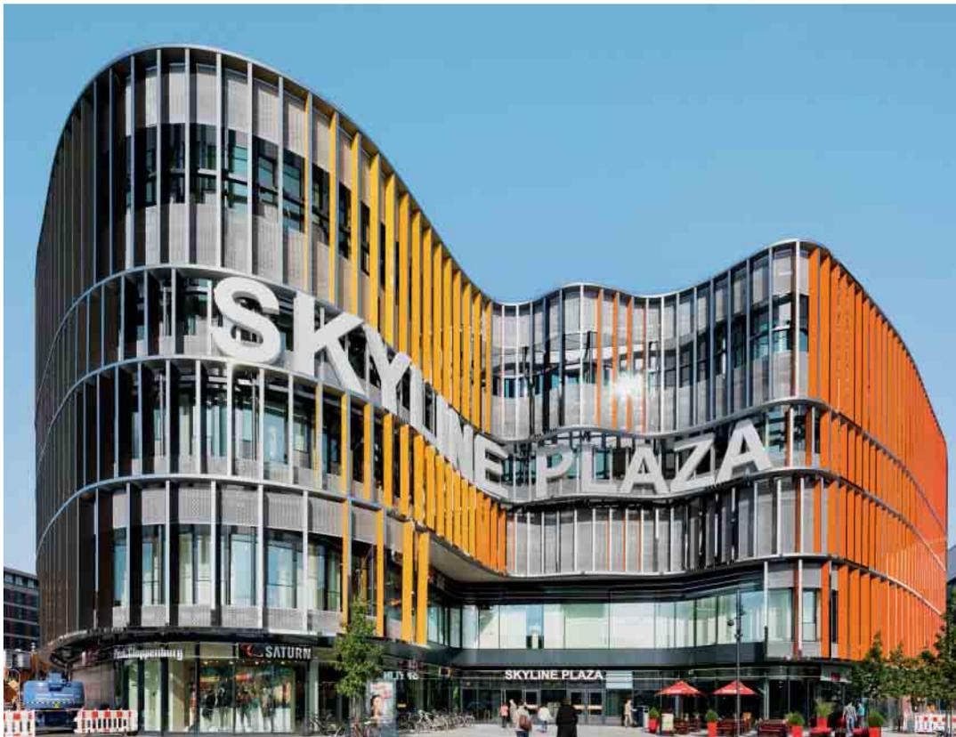
Beim Einkaufszentrum Skyline Plaza in Frankfurt führte anders Metallbau die komplette Fassade aus, zum Einsatz kamen etwa Schüco Schiebetüren, Fenster, Türelemente, Pfostenriegelfassaden und Sonderprofile für die Lamellen. Das Flachdach wurde als „fünfte Fassade“ konzipiert (re.).
